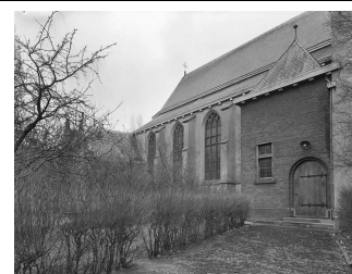
Noordgevel Petruskerk in Woerden vóór de verbouwing
