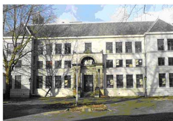
Het voormalige Gerechtsgebouw aan de Hamburgerstraat
