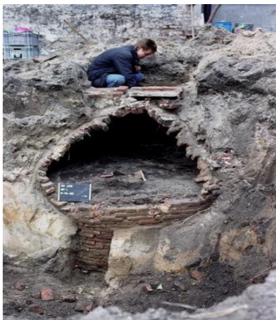
(Bakstenen beerput met koepel, opgegraven in Haarlem (1990) in de Jacobijnestraat. Foto: Jos Fielmich).
